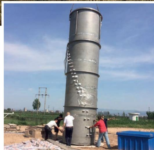
Stationäre Installation von PICO Sonden in einer 8m tiefen Lysimeter Anlage in China (im Betrieb, während der Installation, bei der Einbringung der Türme)
